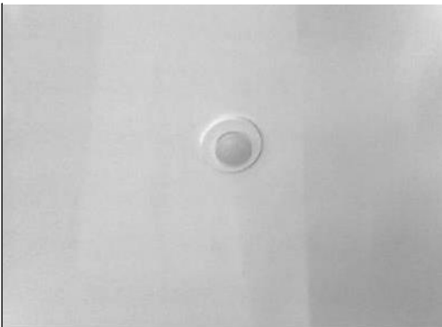
Abbildung 6. Zugangsöffnung (Ansicht von innen)
