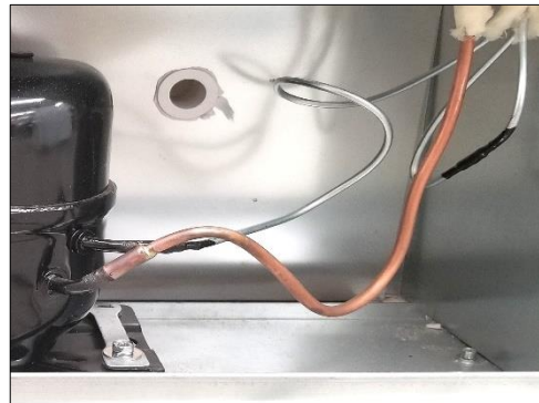
Abbildung 6a. Zugangsöffnung (Ansicht von außen)
