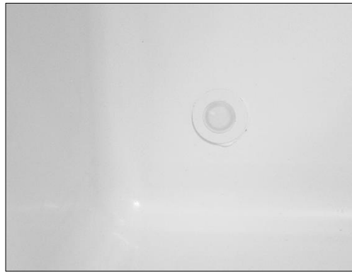
Abbildung 5a. Zugangsöffnung (Ansicht von innen)
